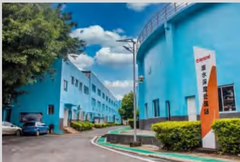
废水深度处理站
