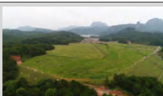
凡口矿尾矿库生态恢复
