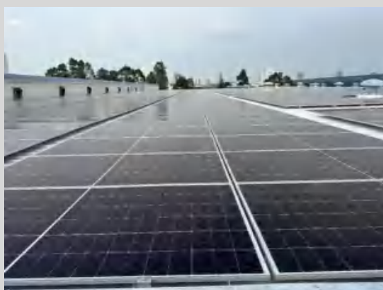
华加日华西公司厂房屋顶光伏发电三期
