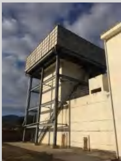
凡口矿率先完成全国首个通风井湿式 共振弦栅除尘净化系统
