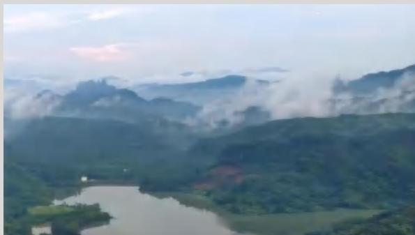
凡口铅锌矿尾矿库
