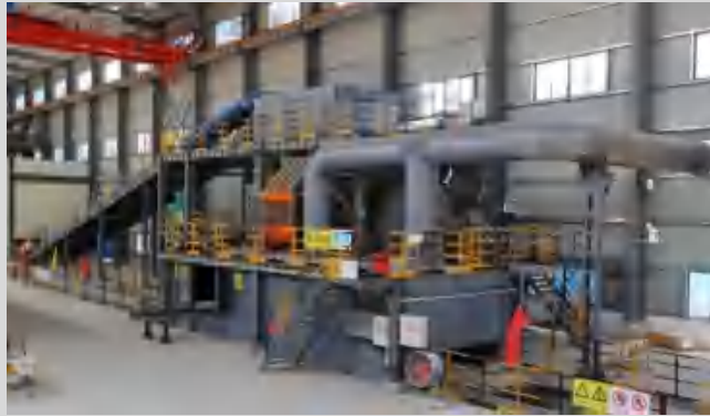
韶关冶炼厂浮渣熔炼炉节能环保升级改造项目
